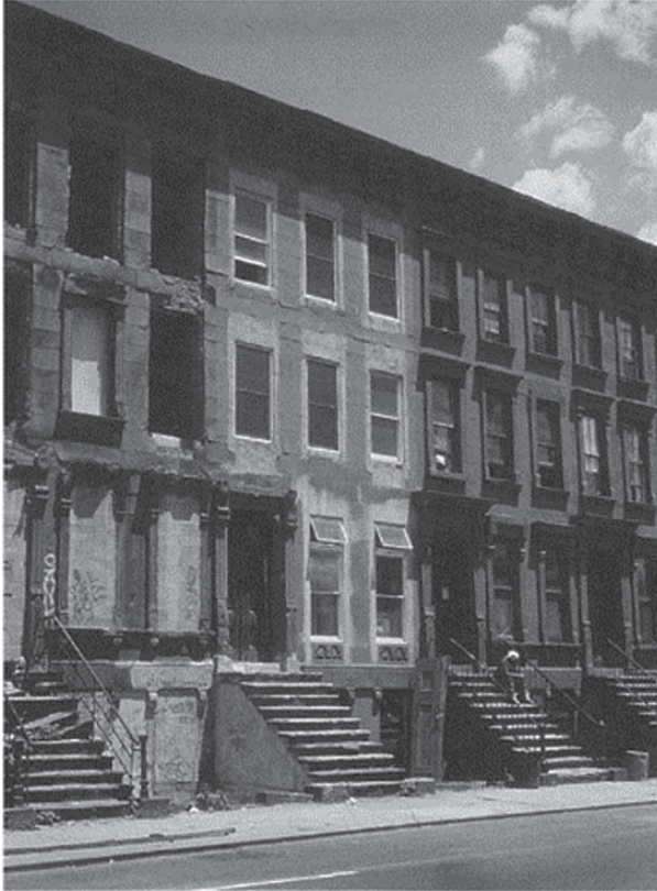
Lámina 7.1. Casas restauradas de ladrillo visto en Harlem, sobre la Avenida Manhattan, 1985.
