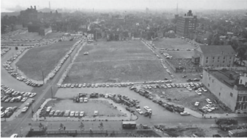
Lámina 6.3. Limpieza del terreno para las Society Hill Towers [Torres de Society Hill], 1961 (cortesía de Archivos Urbanos, Temple University).
